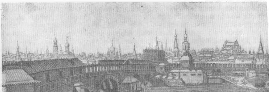
Каменный мост через Москва-реку в 1707 г. (Гравюра, напечатанная в 1707—1708 гг. в Москве).
